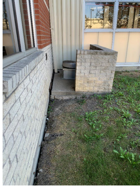
Crawl Space Exhaust Fan Pads
